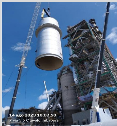
Montaje de reactor RISER para incremento de
