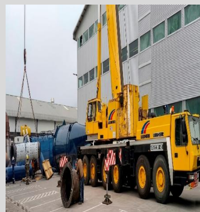
Construcción y montaje de ductos para transporte de
