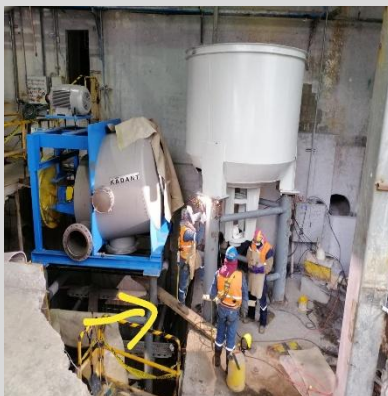
Diseño, construcción y montaje de planta de recuperación de pulpa de papel.
